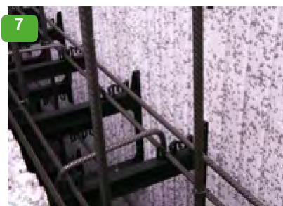
Поставете хоризонталната армировка (клетки или единични свободни жезла) върху първия пласт в съответните отвори в горната част на стремената.
