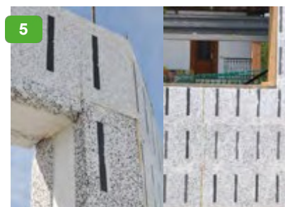
Направете fugи, за предпочитане при вратите и прозорците (вижте на следващата страница)
