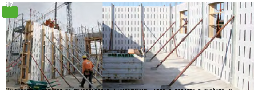
Закрепете системата за подравняване и нивелиране, като я завийте в скобите на вътрешната повърхност на блоковете. Затегнете самонарезните винтове с отвертка на ниска скорост, за да не прегреете скобата. Затегнатите винтове имат якост на изтегляне над 100 kg. Не завивайте подпората при последния курс нагоре (вижте ръководството за подпори)
