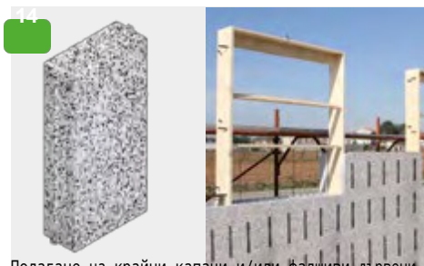
Пологане на крайни капаци и/или фалшиви дървени кутии (рамки), подходящо укрепени с помощта на подпори и скоби
