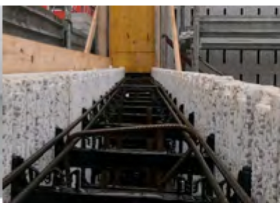
Само за първия ред конзолите на ъгловите елементи се свързват със съседните линейни елементи с телени или пластмасови ленти. Повторете операцията във връзките на блоковете, както е посочено в точка 5 по-горе.
