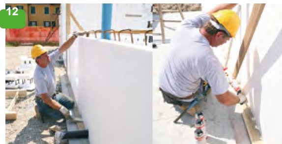
Компенсирате неравностите на основата с клинове или дървени подложки. След като завършите регулиране, евентуално закрепено с полиуретанова пяна
