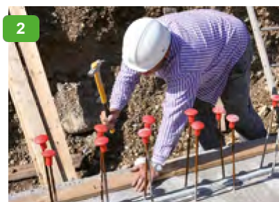
Закрепете лентите за подравняване с пирони или винтове
