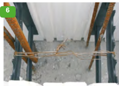
Само за първия ред конзолите на ъгловите елементи се свързват със съседните линейни елементи с телени или пластмасови ленти. Повторете операцията във връзките на блоковете, както е посочено в точка 5 по-горе.
