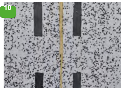
Фугата на втория ред трябва да съпада с тази на долния ред до върха на стената (вижте обратната страна).
