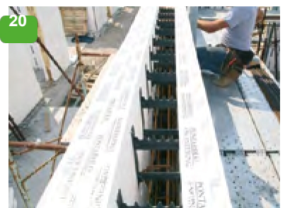
Преди отливане защитете горните зъби на съединителя на блока с тиксо или друг наличен материал.
