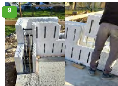
Пологане на втория пласт, като се започне от ъглите и се продължи към разместване на блоковете под формата на "тухла"
