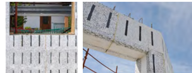
За да се получат измервания извън формата, ще бъде необходимо да се отреже Climablock®. Препоръчваме ви да режете вертикално на всеки пласт в една и съща позиция и за предпочитане под и над прозорци или врати.
