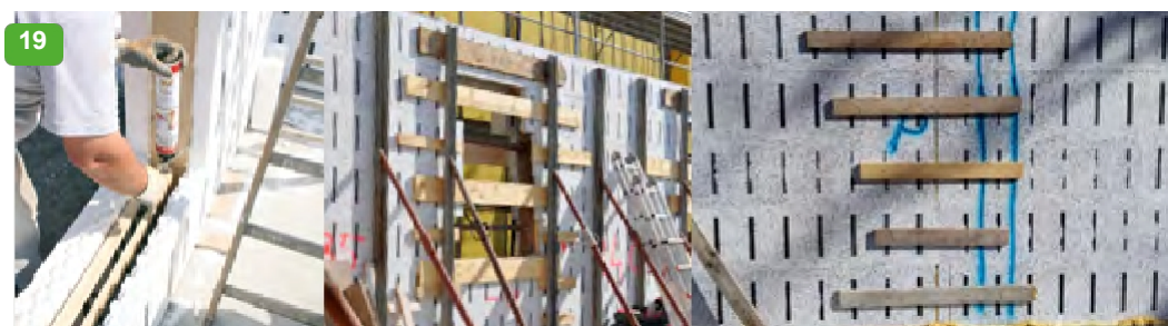
Осигурете херметичност на връзките с дъски, завинтени в съответните скоби (поне 4 фиксатора), като поставите за предпочитане за всеки курс вътрешно и външно. Използвайте ленти, скоби или други средства за поддръжане на вертикалните части на отворите. Запнете, когато е необходимо, за да предотвратите разливането на вода от сместа или за укрепване на направените закрепвания и корекции
